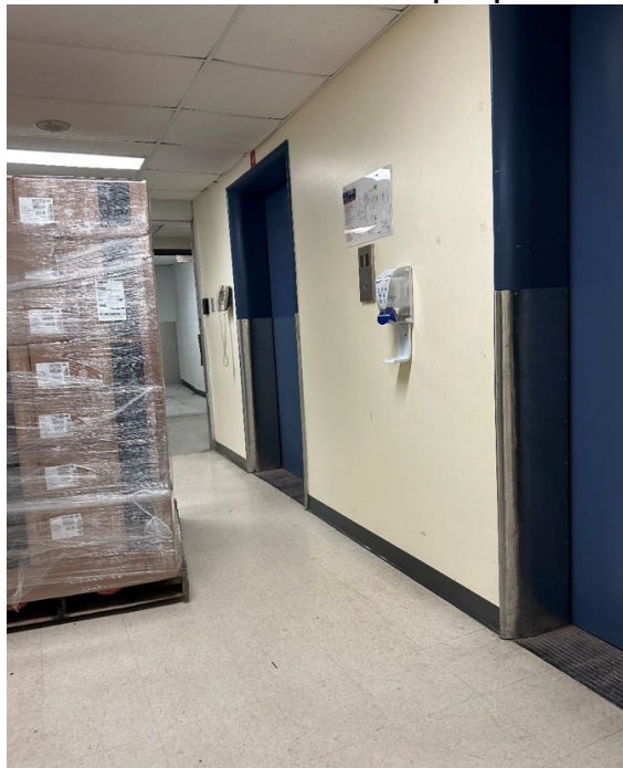
Figure 39 Photo de l'accès à l'ascenseur bloqué par une palette de livraison
