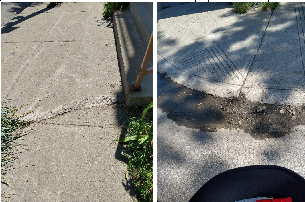
Figure 27 Photos de trottoirs en mauvais état qui posent un risque de chute
